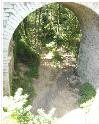
Le Bozançon à sec en amont de la confluence avec le Gier (juillet 2009)
