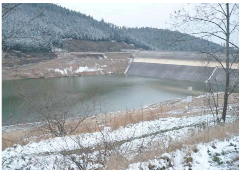
Le barrage du Dorlay en cours de vidange (décembre 2009)
